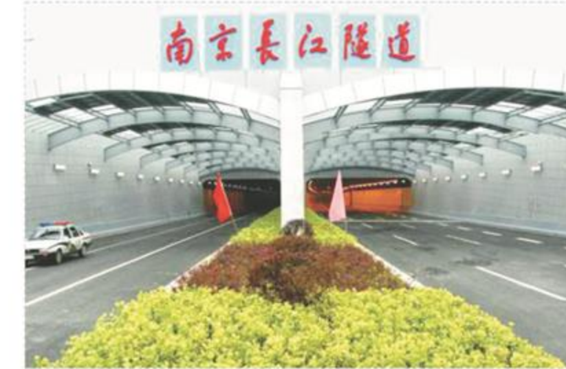
南京长假隧道 Nanjing Yangze River Tunnel
