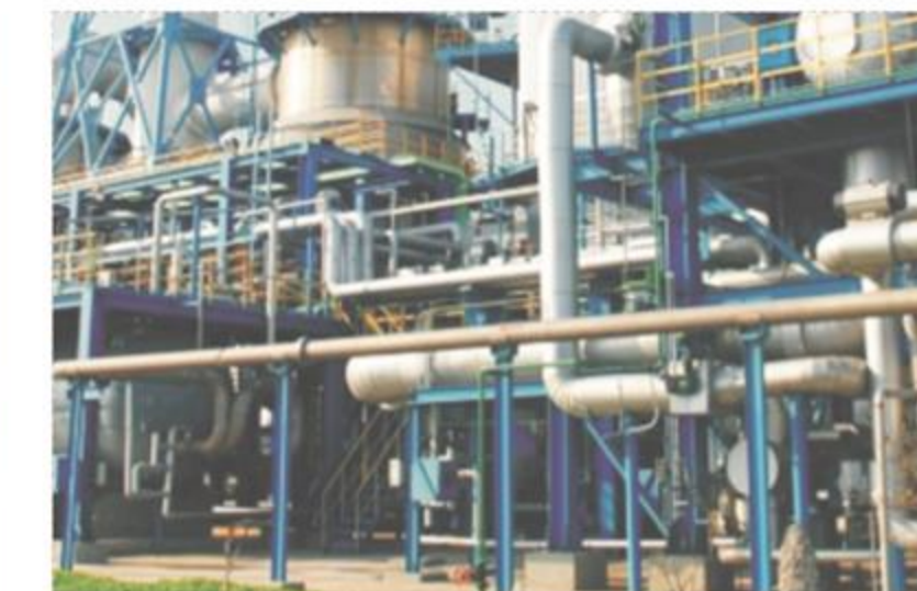
内蒙古煤化工项目 Inner Mongolia Coal Chemical Project
