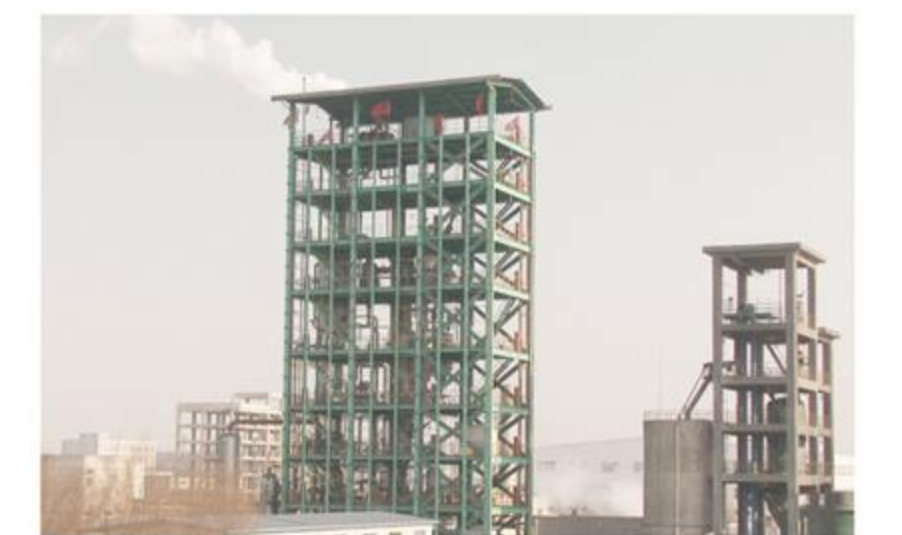
晋煤300万吨煤制造油项目 Shanxi Coal Manufacturing Oil Project
