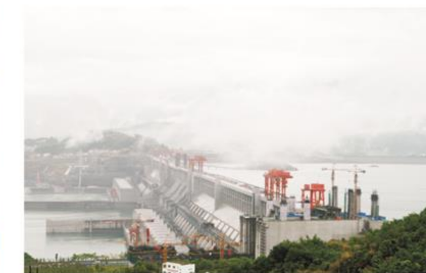
三峡工程 Three Gorges Dam
